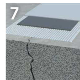
7 Abdichtung von Rissen
